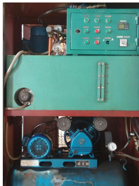
Рис. 2. Маслостанция шаровой мельницы с логическим контроллером SiemensLogo
