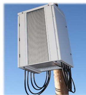
Рис. 2. Вольтодобавочный трансформатор «Бустер Энсто»
