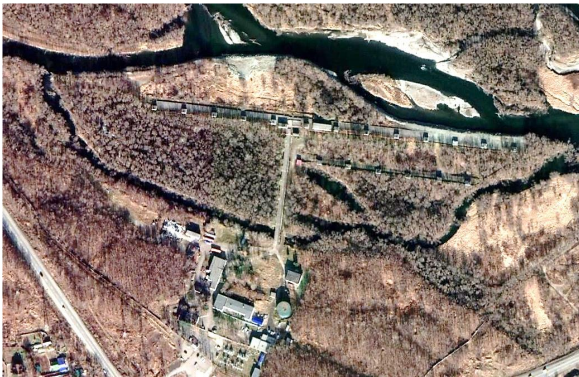
Рис. 1. Водозабор «Авачинский». Общий вид
