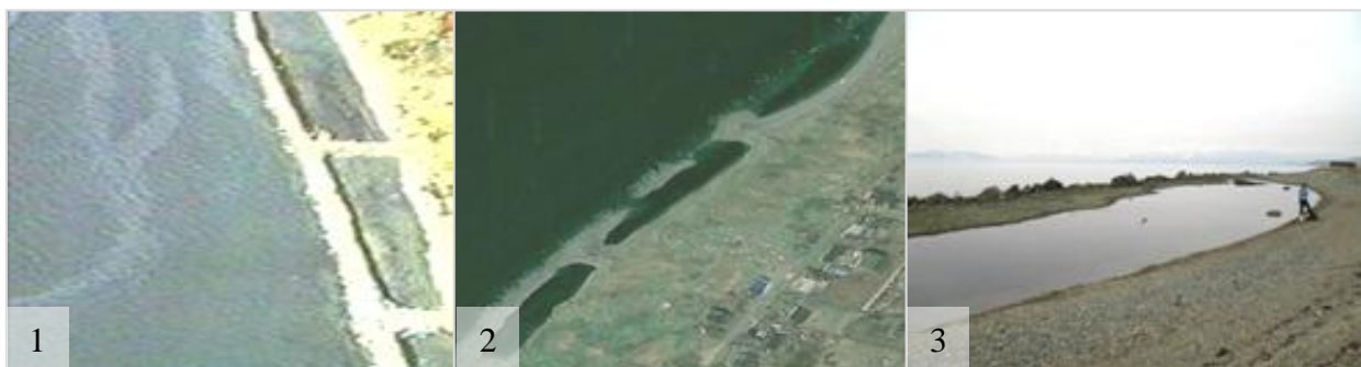
Рисунок 39 – Искусственная дамба, возведенная на берегу Авачинской губы в 1990-х г. 1, 3 – карманы дамбы во время отлива; 2 – карманы дамбы во время прилива
